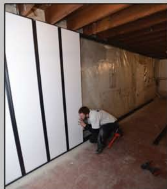
5. Installing E3 Wall Foam and E3 I-Beams
