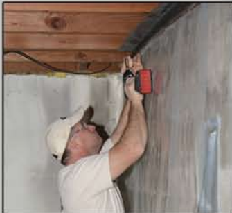
4. Attaching E3 Top Plate
